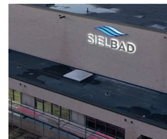
Zur dunklen Jahreszeit erstrahlt Ende 2021 das Leuchtlogo an der Fassade.
