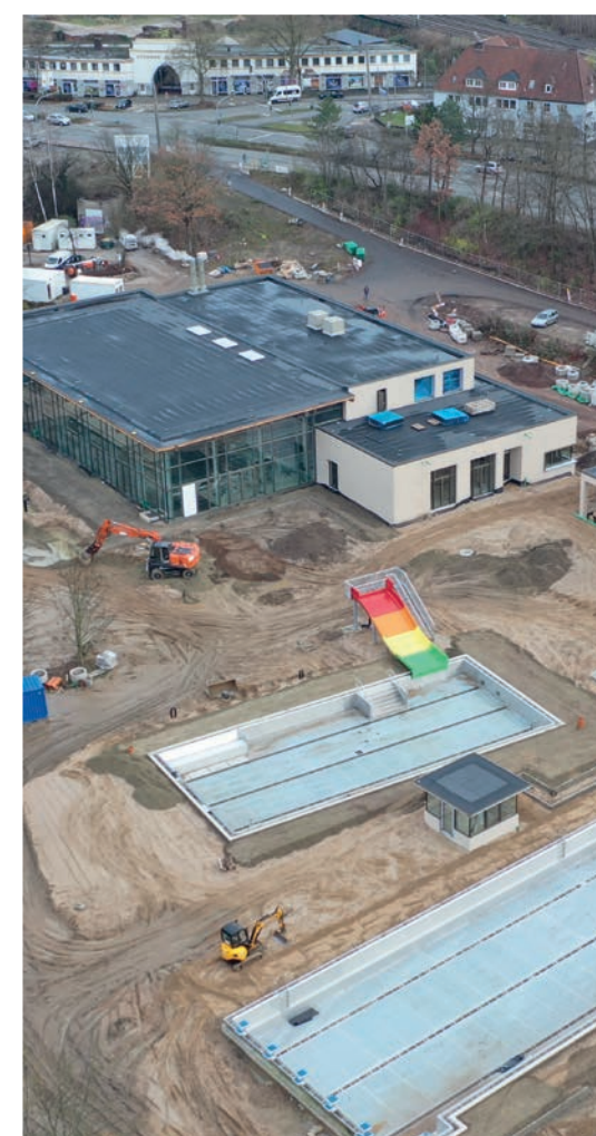
Die Landschaftsbauarbeiten laufen zum Jahresende 2021 auf Hochtouren.
