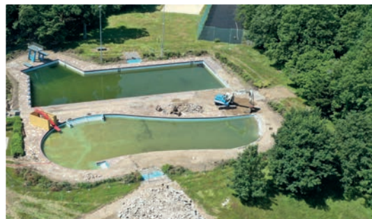
Das alte Freibad wird im Sommer 2020 abgerissen.
